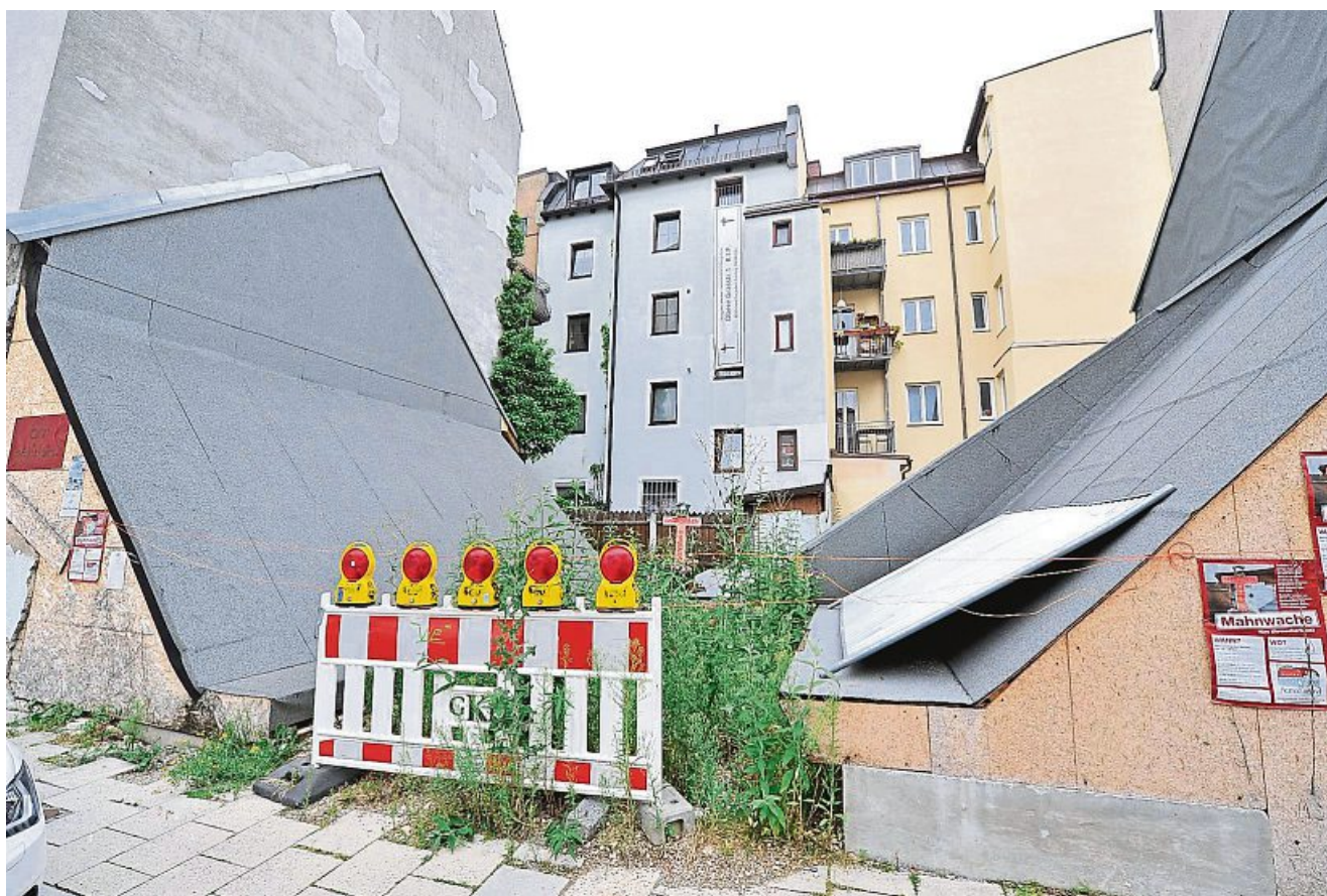
Eine klaffende Lücke: Das Uhrmacherhäusl in Giesing ist 2017 in einer Nacht-und-Nebel-Aktion abgerissen worden. Die Stadt wollte mit dem Eigentümer Andreas S. und dessen Firma eigentlich nicht mehr zusammenarbeiten. SIGI JANTZ
